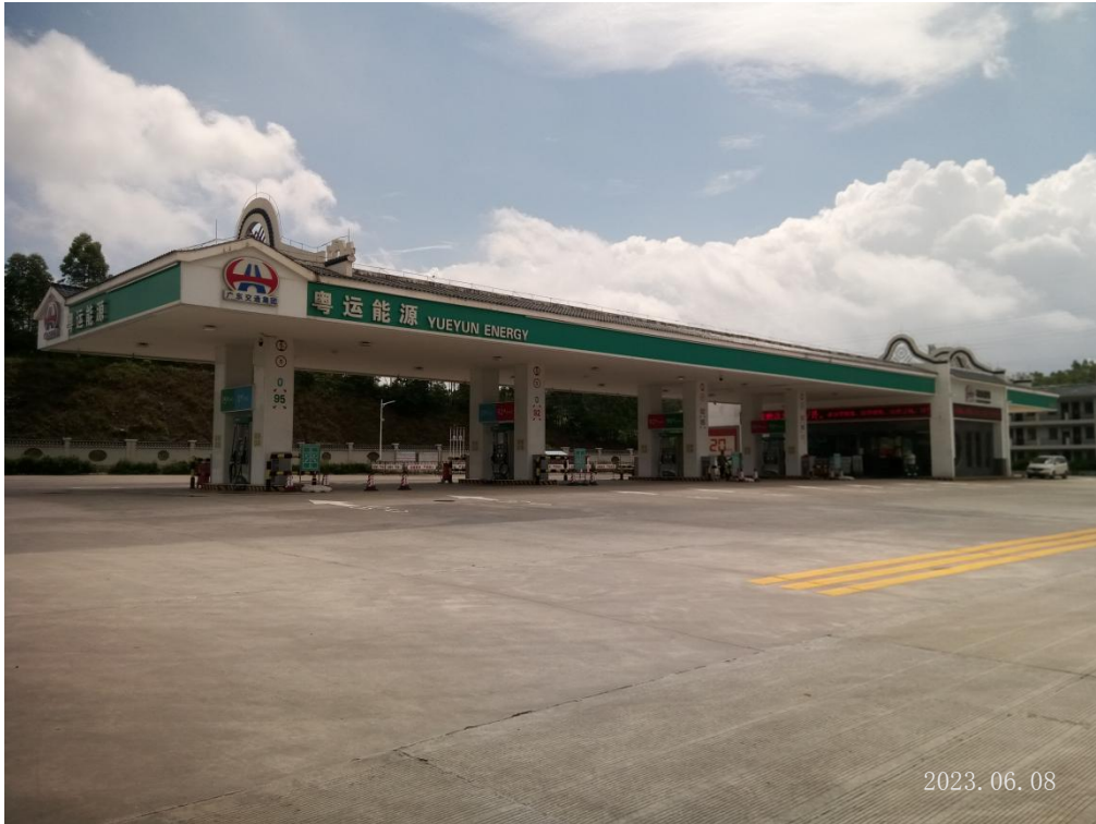
广东通驿高速公路服务区有限公司清远服务区北区加油站现场勘察影像：
