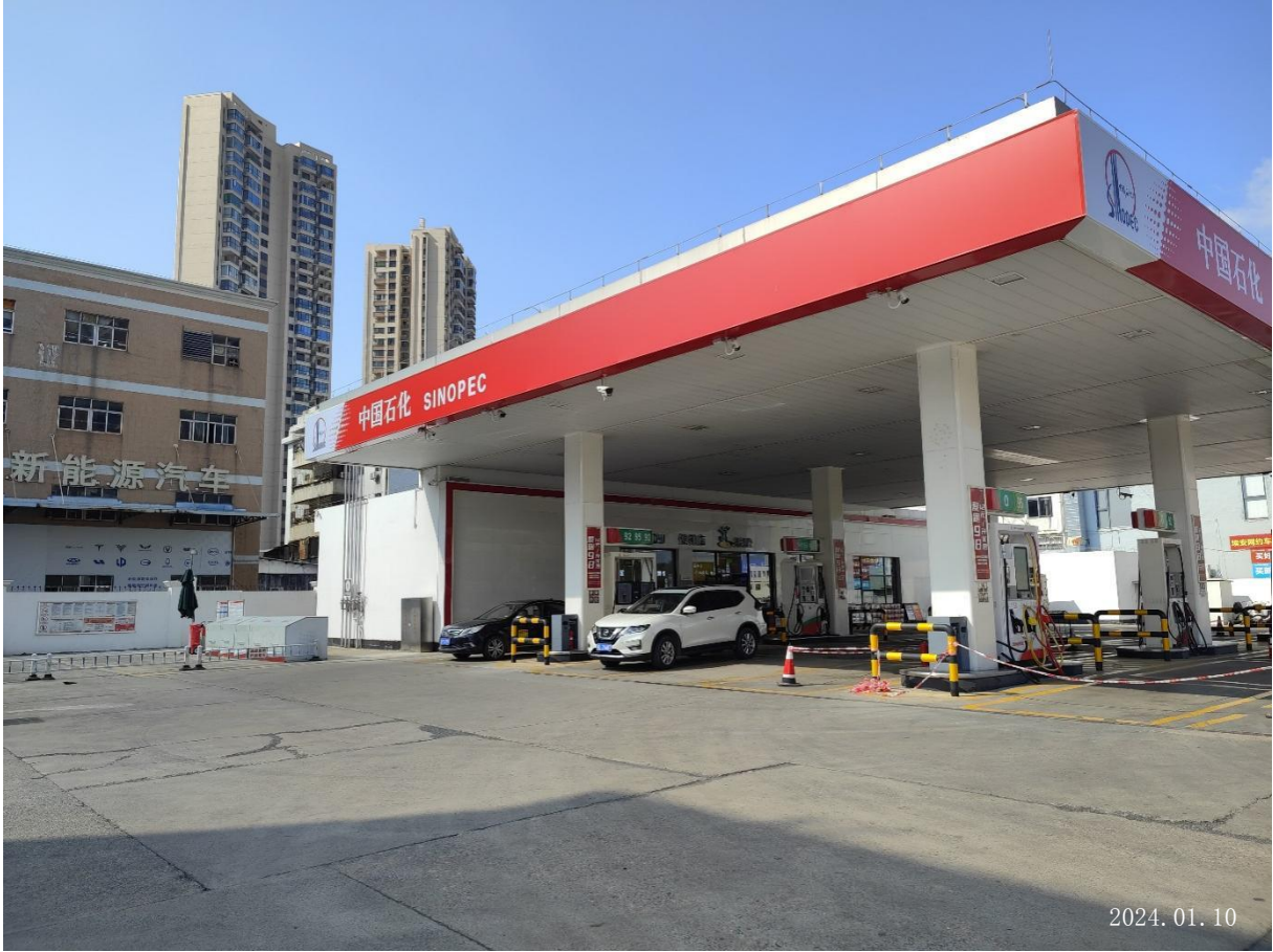
中国石化销售股份有限公司广东惠州大湖溪加油站现场勘察影像：
