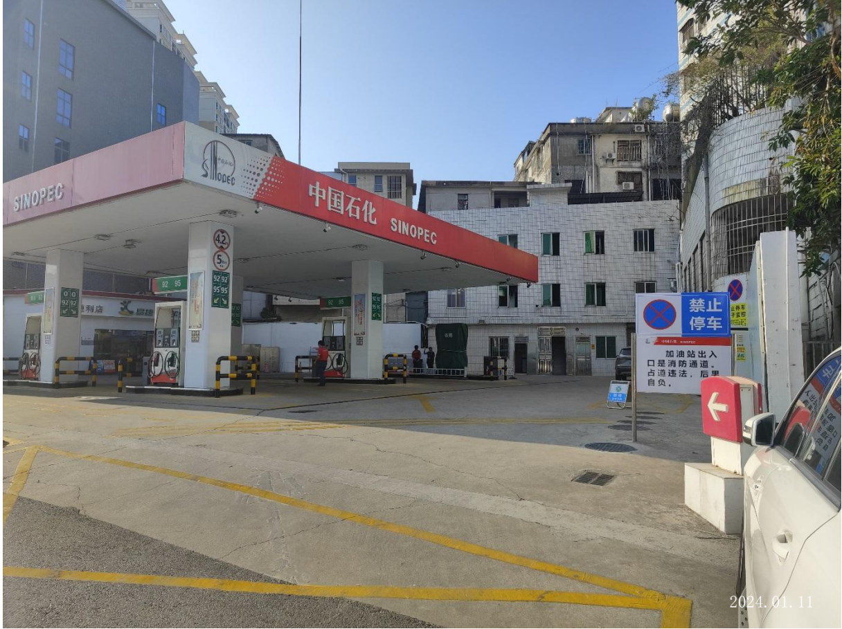
中国石化销售股份有限公司广东惠州惠阳顺达加油站现场勘察影像：
