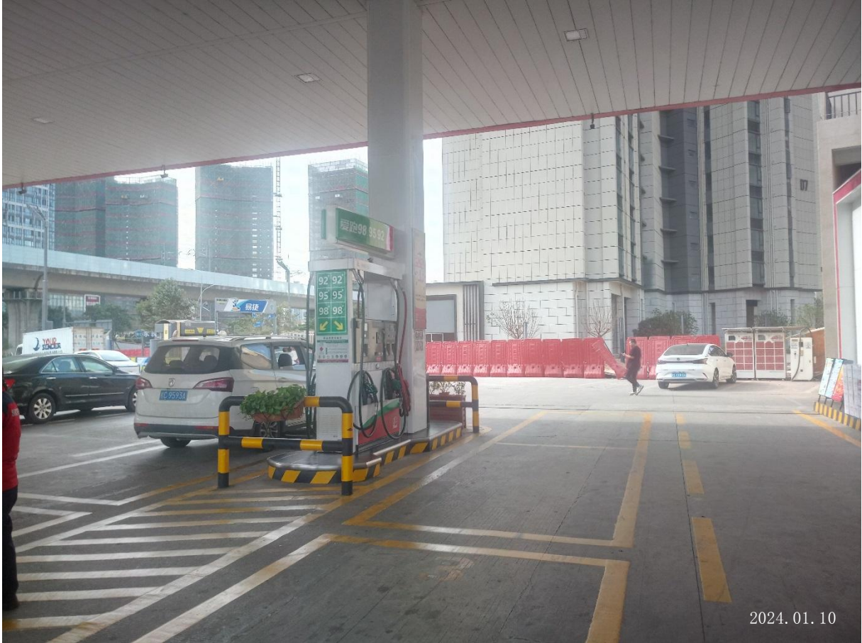
中国石化销售股份有限公司广东惠州陈江加油站现场勘察影像：
