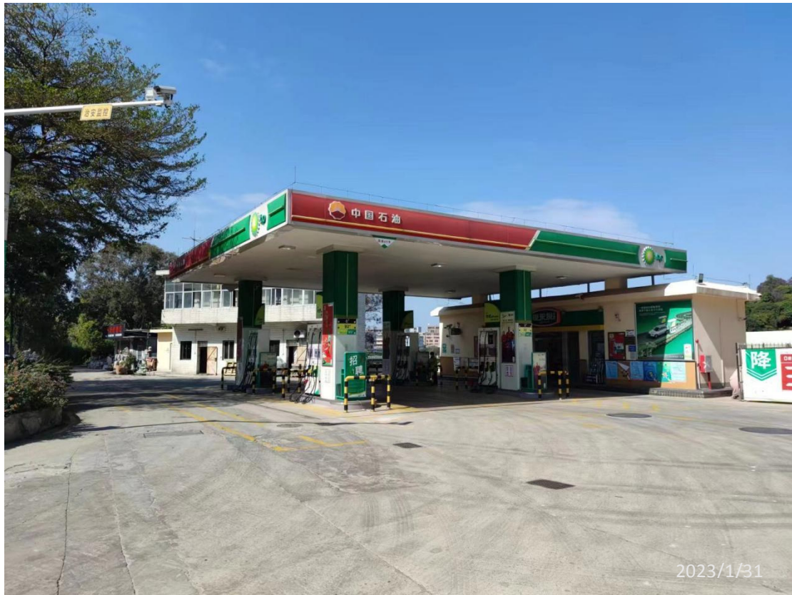
中油碧辟石油有限公司东莞沙步加油站现场照片
