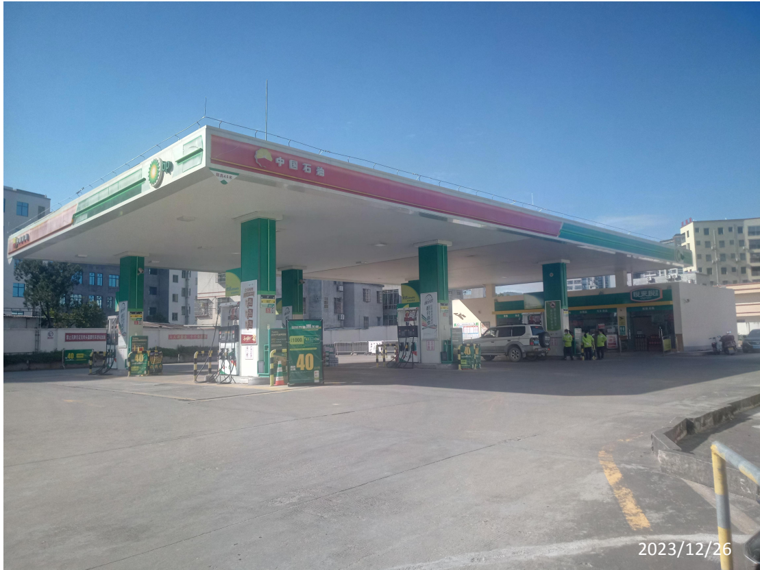
中油碧辟石油有限公司河源分公司现场勘察照片：
