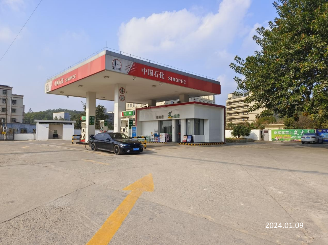
中国石化销售股份有限公司广东惠州新江加油站现场勘察影像：
