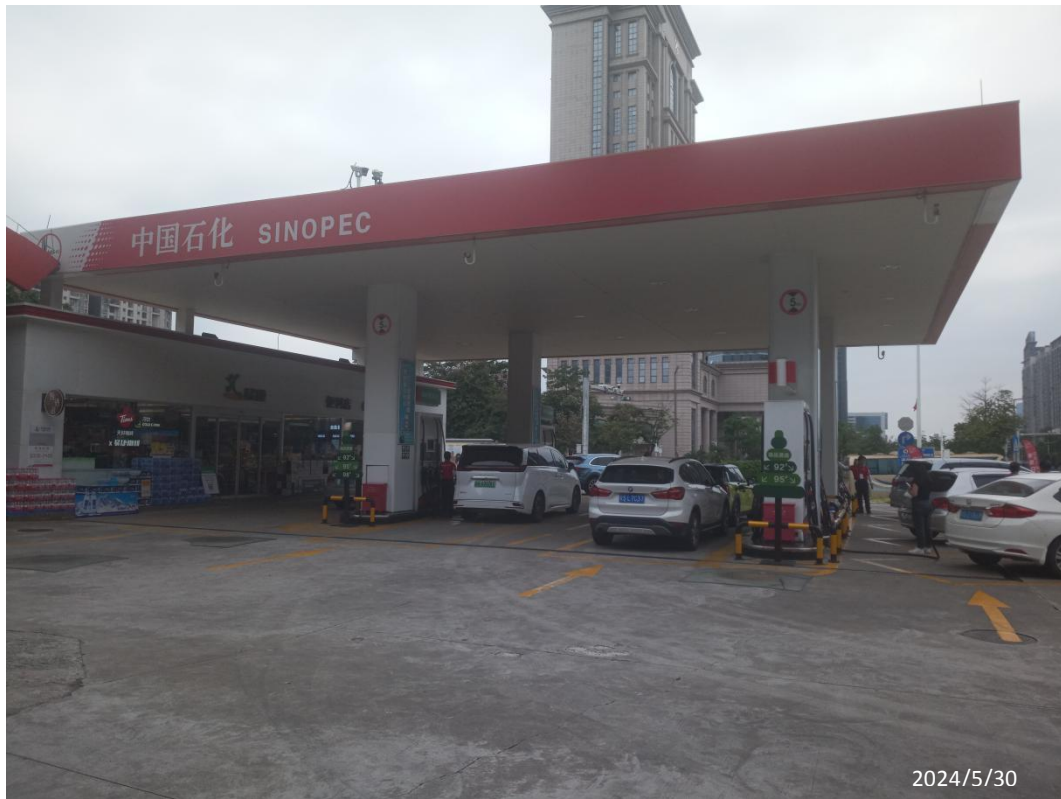
中国石化销售股份有限公司广东东莞南城四环中加油站现场照片
