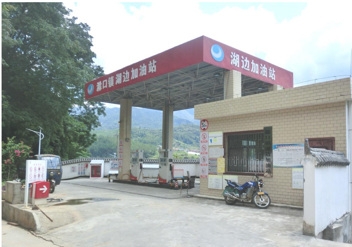
图 1：加油站全景照片
