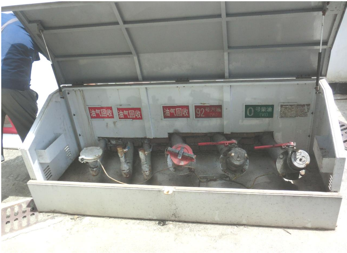
图 3：加油站卸油口照片
