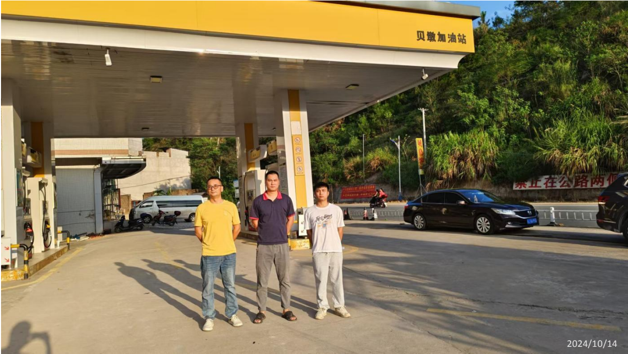
和平县贝墩加油站现场勘察影像：
