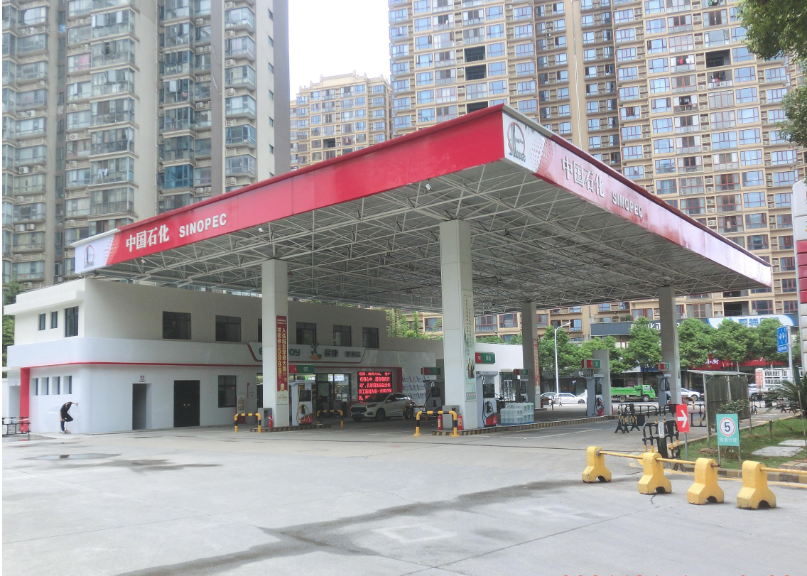
图 1 加油站全景照片
