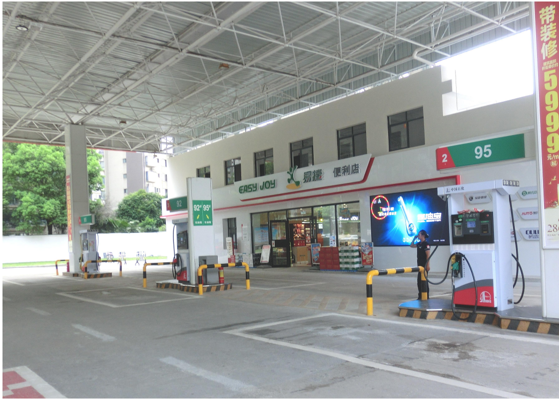
图 3 加油站加油机照片
