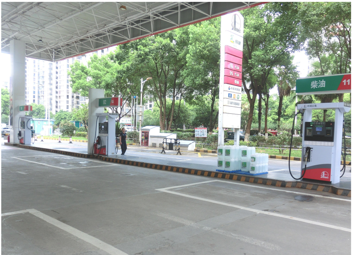
图 2 加油站加油机照片
