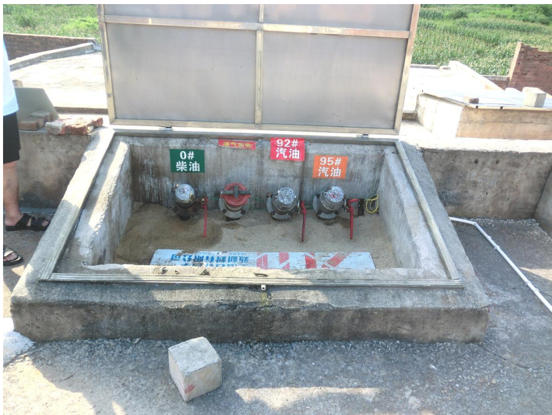
图 4：加油站卸油口照片
