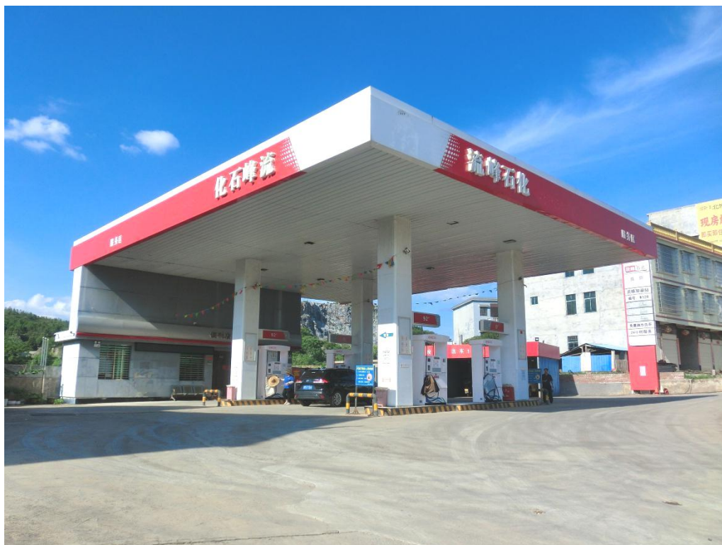
图 1：加油站全景照片
