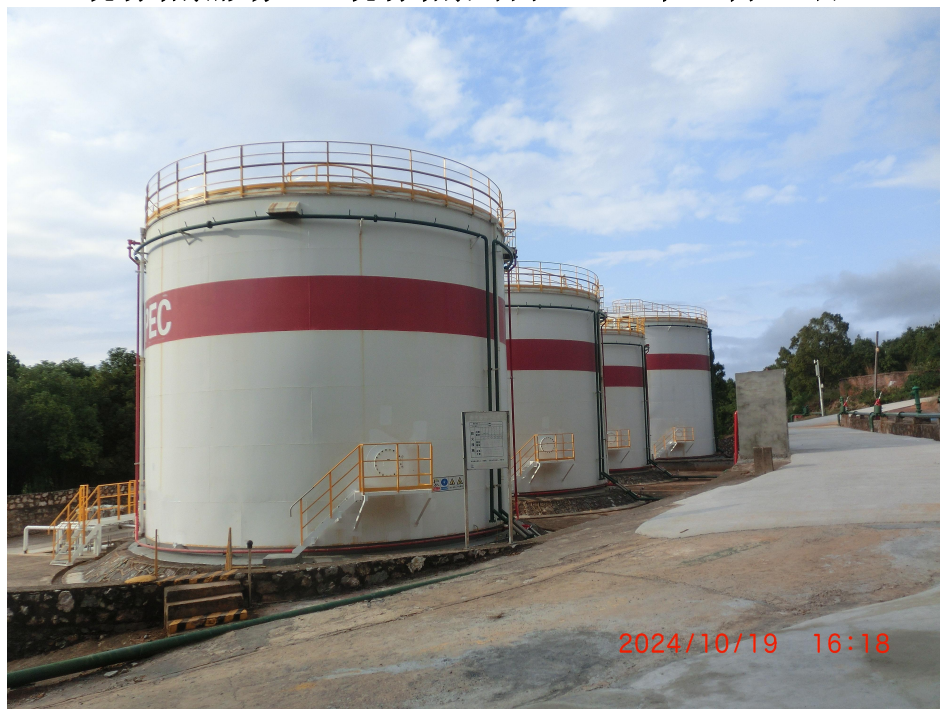
图 1 油库储罐区照片
