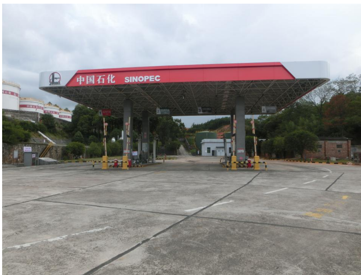
图 2 油库发油区照片
