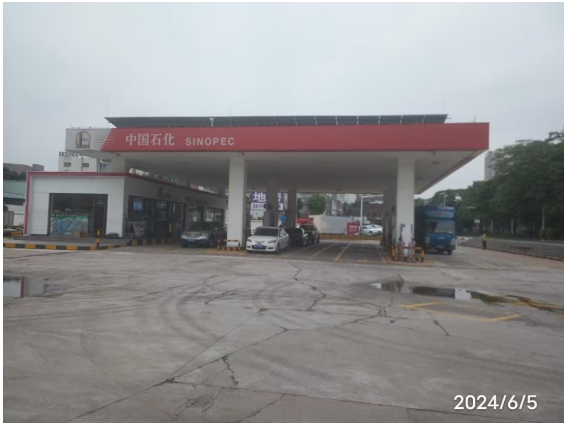
中国石化销售股份有限公司广东东莞沙田福隆加油站现场照片
