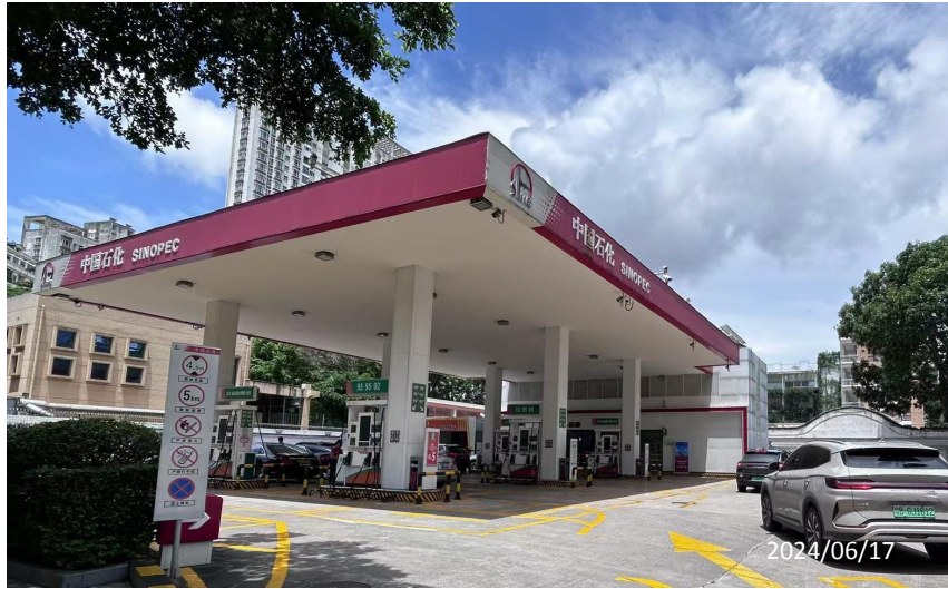
中国石化销售股份有限公司广东深圳天诚东港加油站现场勘察影像：
