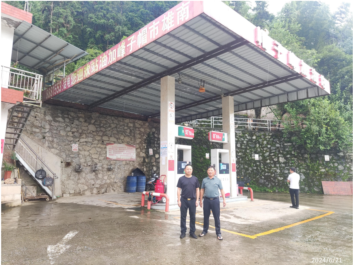
南雄市帽子峰加油站现场勘察影像：
