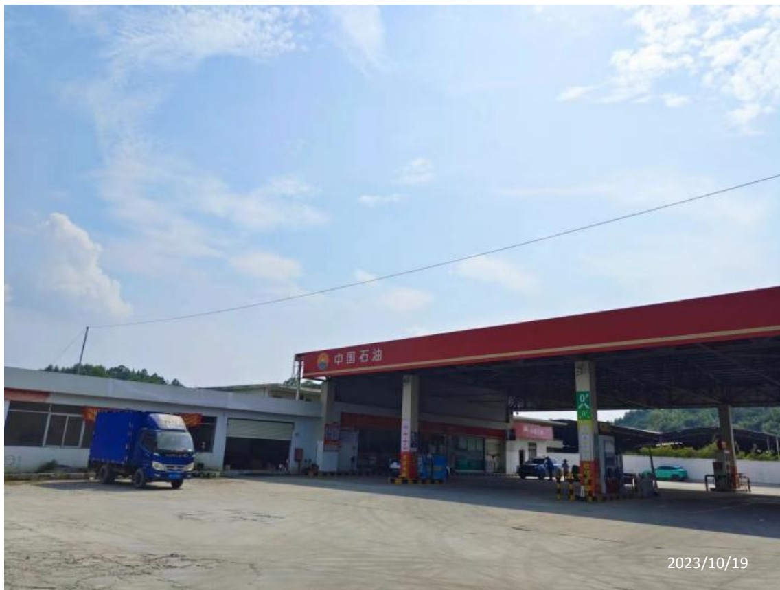
中国石油天然气股份有限公司广东肇庆高要加富加油站现场勘察影像：
