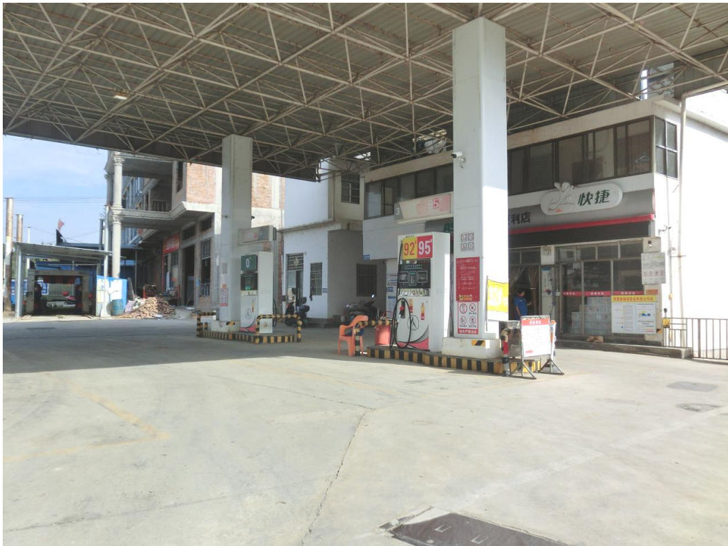
图 2：加油站加油机照片
