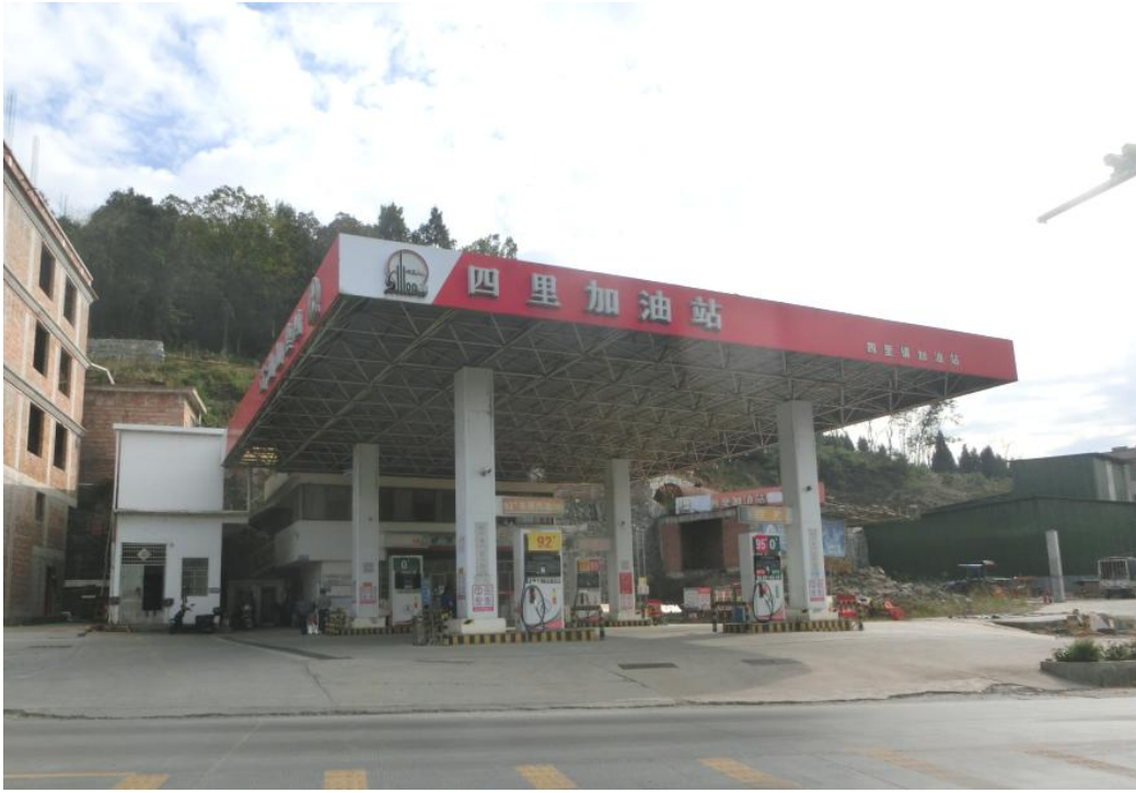
图 1：加油站全景照片
