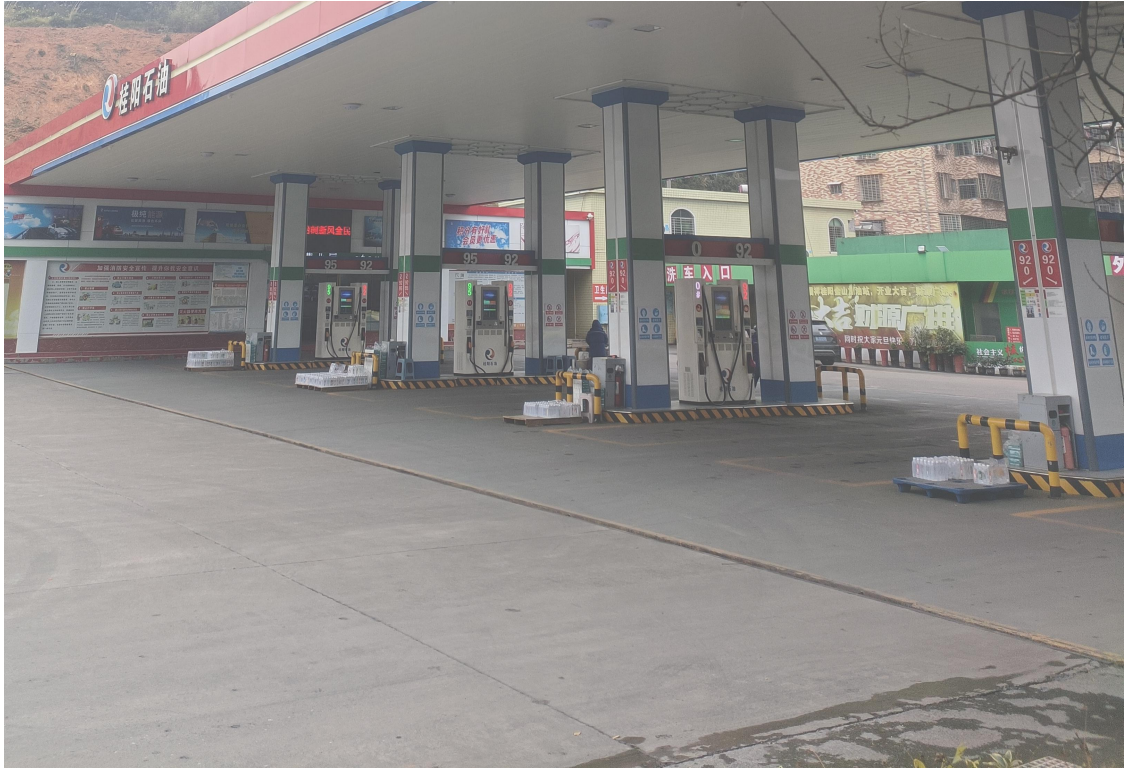
现场勘察影像：（现场勘察时间：2024年12月11日）
