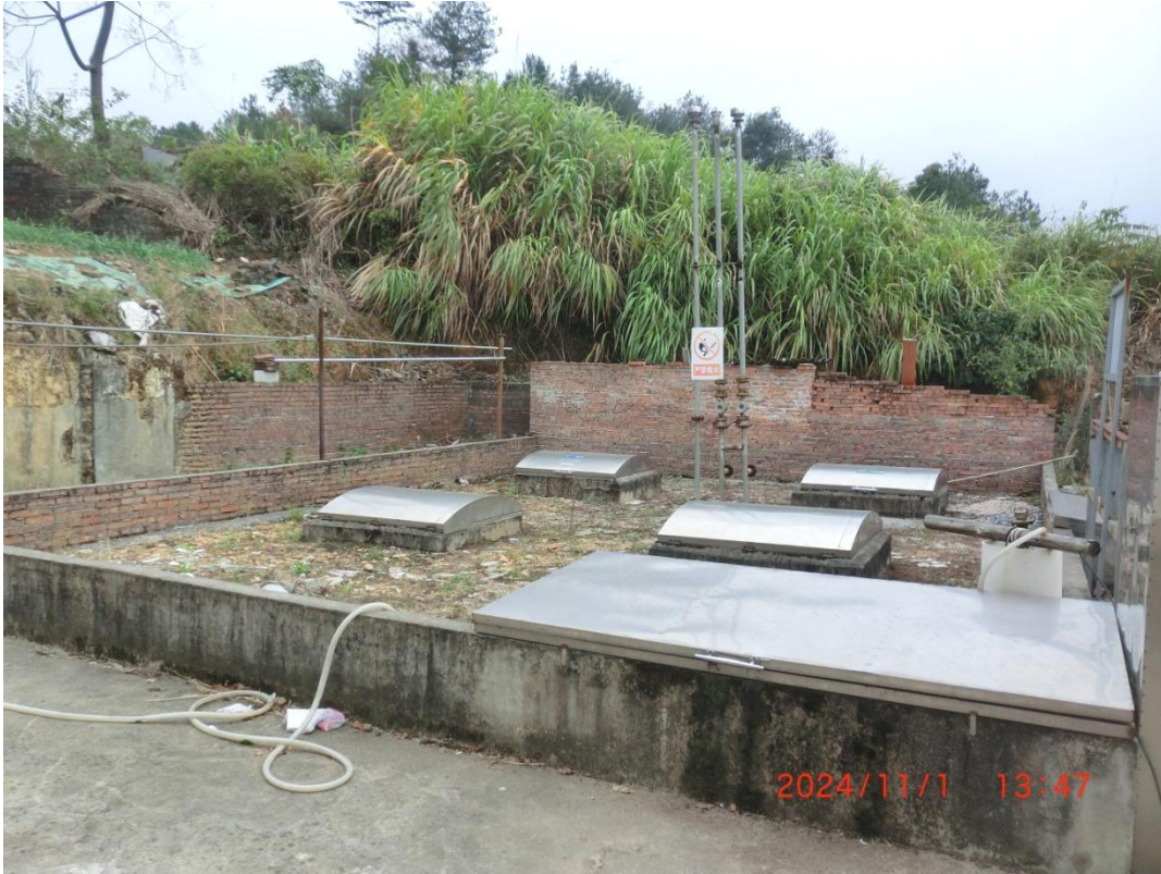
现场勘察影像：（现场勘察时间：2024年11月1日）
