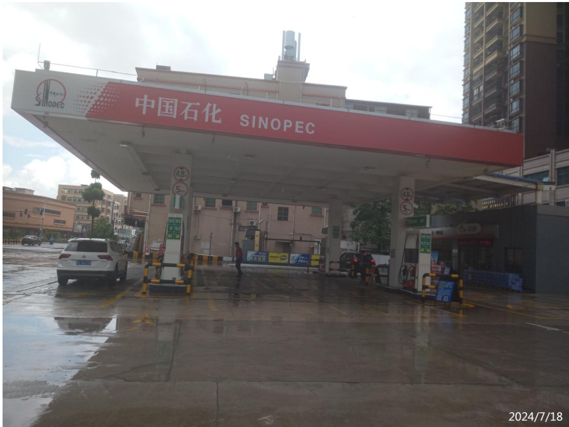
中国石化销售股份有限公司广东惠州博罗粤发加油站现场照片
