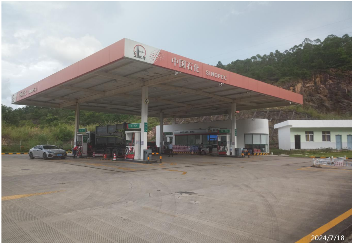
中国石化销售股份有限公司广东惠州惠阳穗淡古屋加油站现场照片
