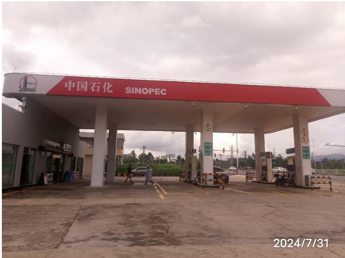
中国石化销售股份有限公司广东惠州龙门西埔加油站现场照片
