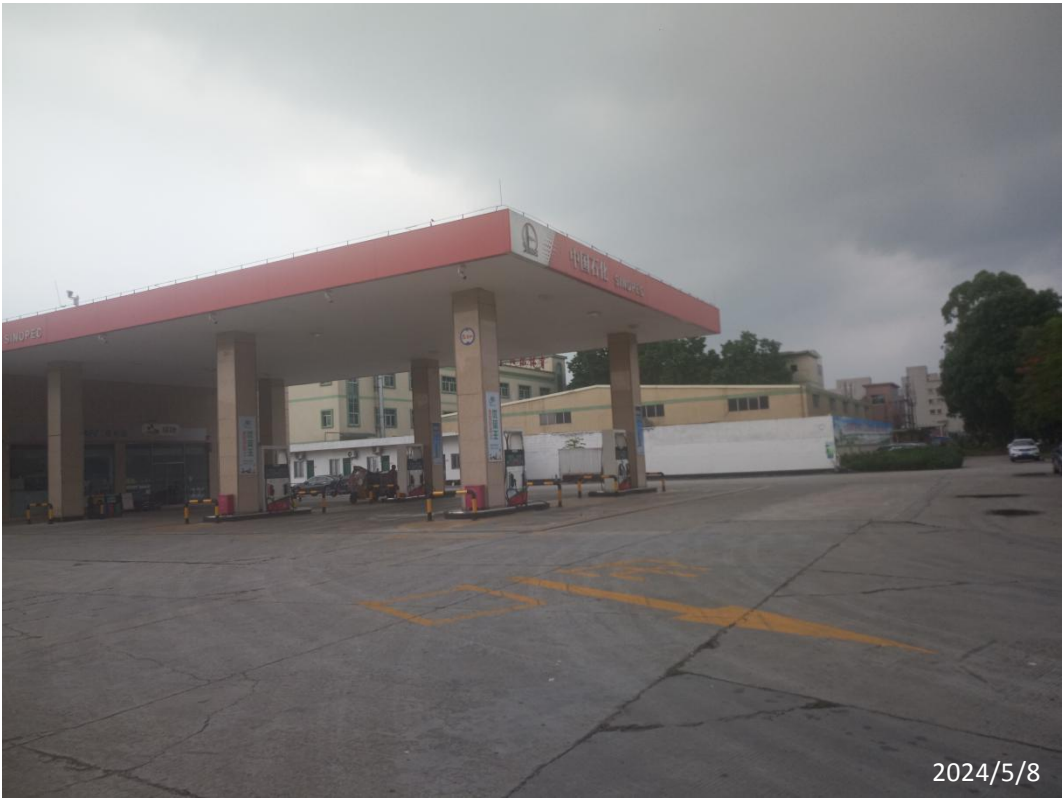
中国石化销售股份有限公司广东东莞谢岗供销社油料供应站现场照片
