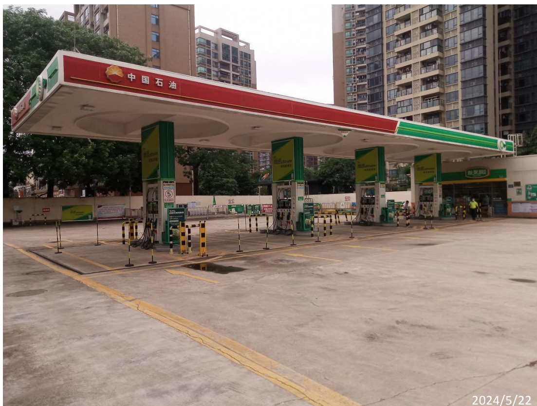
中油碧辟石油有限公司东莞大岭山加油站现场照片
