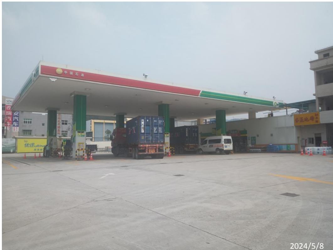
中油碧辟石油有限公司东莞田美加油站现场照片
