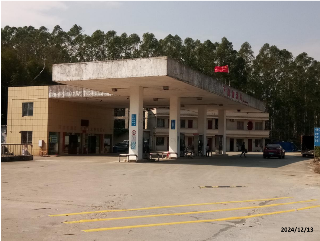
恩平市沙湖镇下凯加油站现场照片
