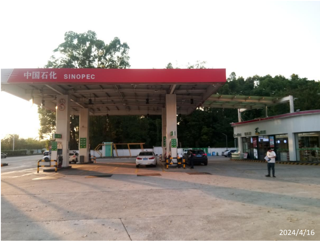
中国石化销售股份有限公司广东惠州三塘加油站现场照片
