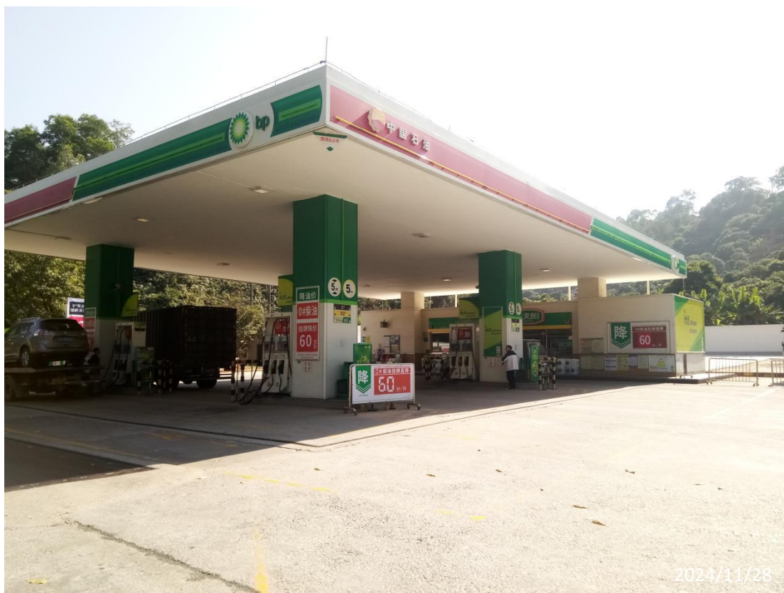
中油碧辟石油有限公司东莞凌峰加油站现场照片
