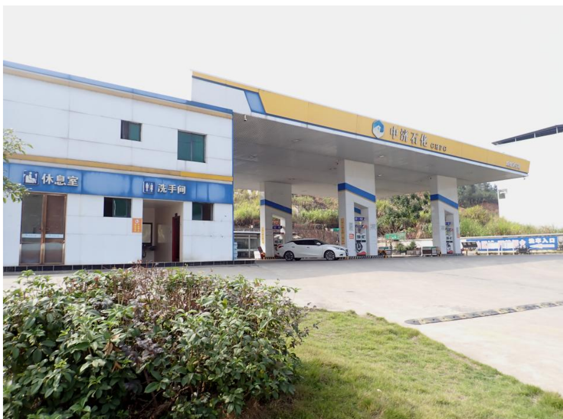
郴州市中闽石油化工有限公司安仁县城北永安加油站现场勘察影像： (现场时间：2024 年 11 月 1 日)
