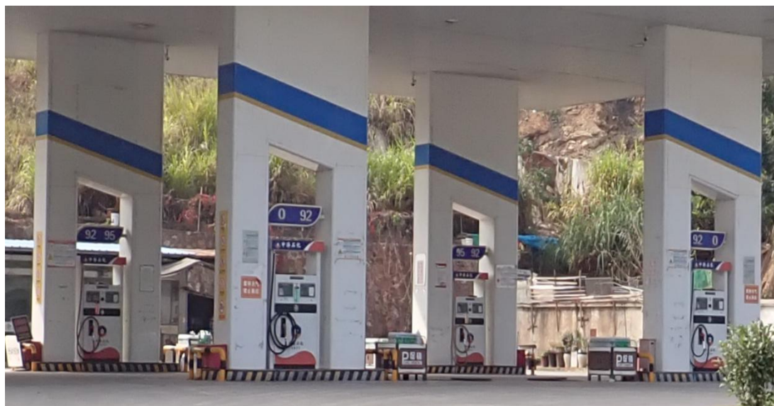
图 2：加油站加油机照片
