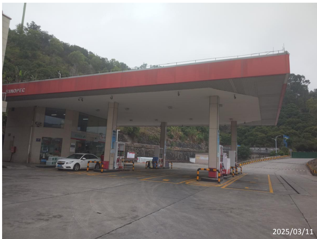
中国石化销售股份有限公司广东东莞樟木头威达加油站现场照片
