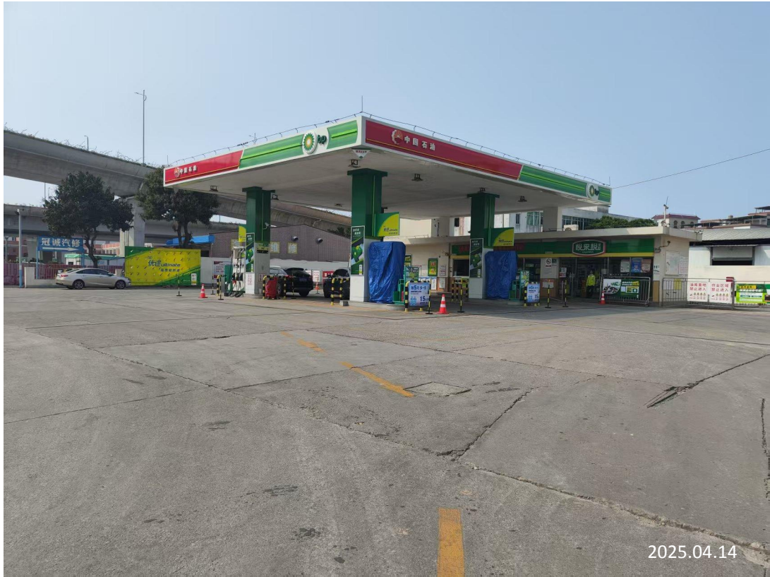
中油碧辟石油有限公司广州雅瑶加油站现场勘察影像：
