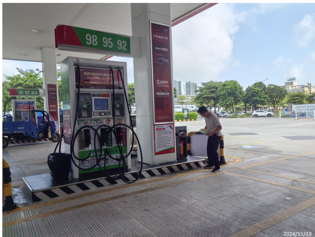
广东韶关西郊加油站改建油品管线项目现场勘察影像：
