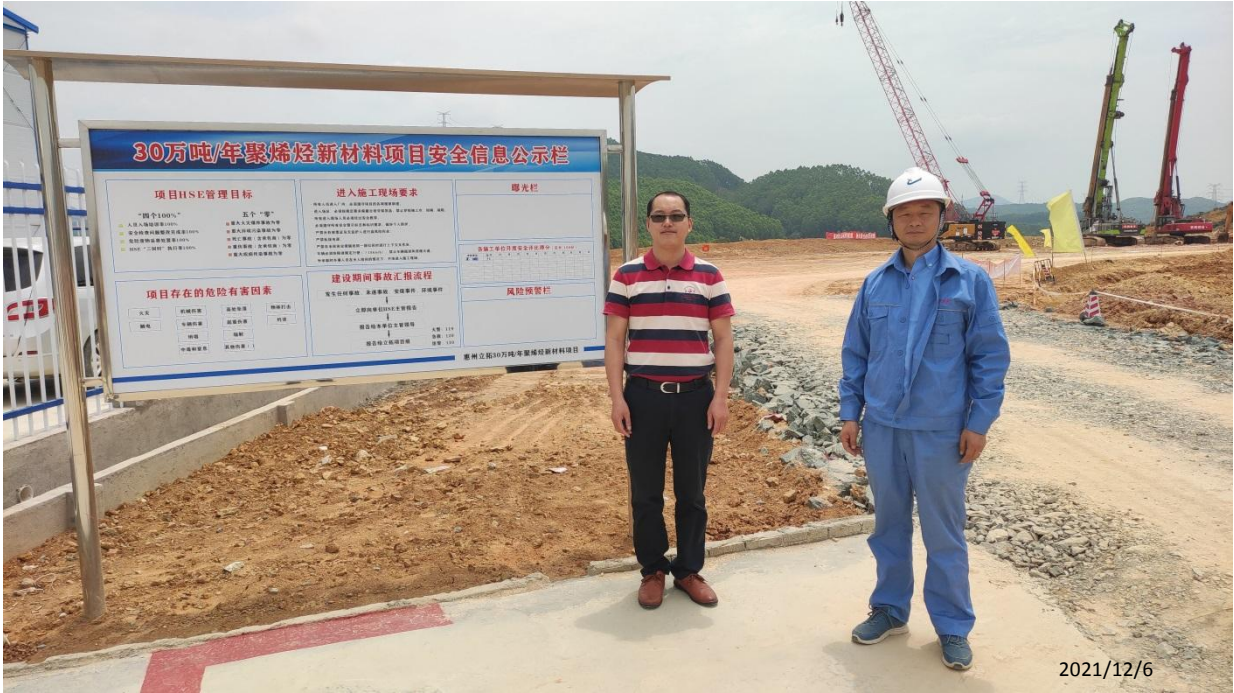
惠州立拓新材料有限责任公司 30 万吨/年聚烯烃新材料项目安全评价现场勘察影像：
