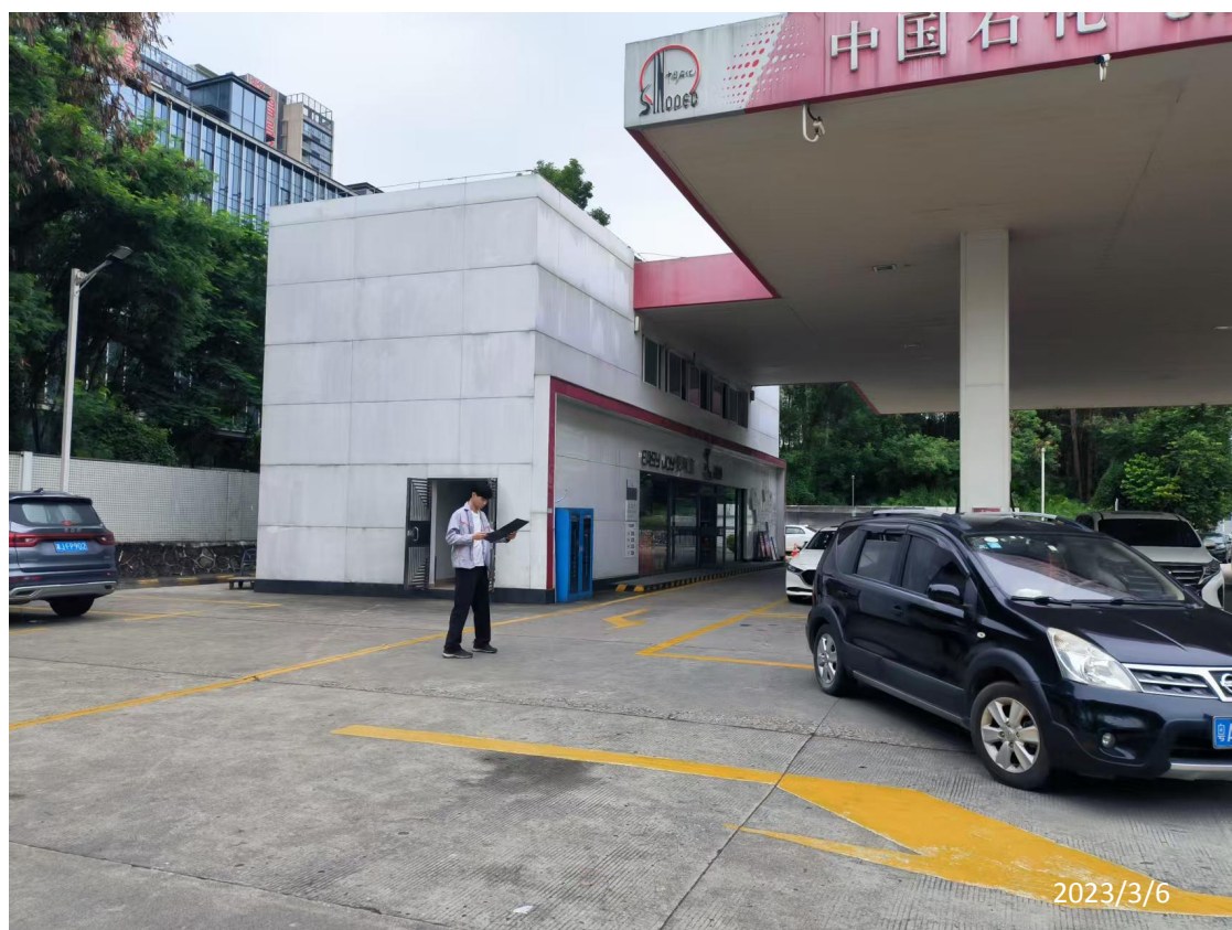
中国石化销售股份有限公司广东深圳黎光东加油加气站现场勘察影像；
