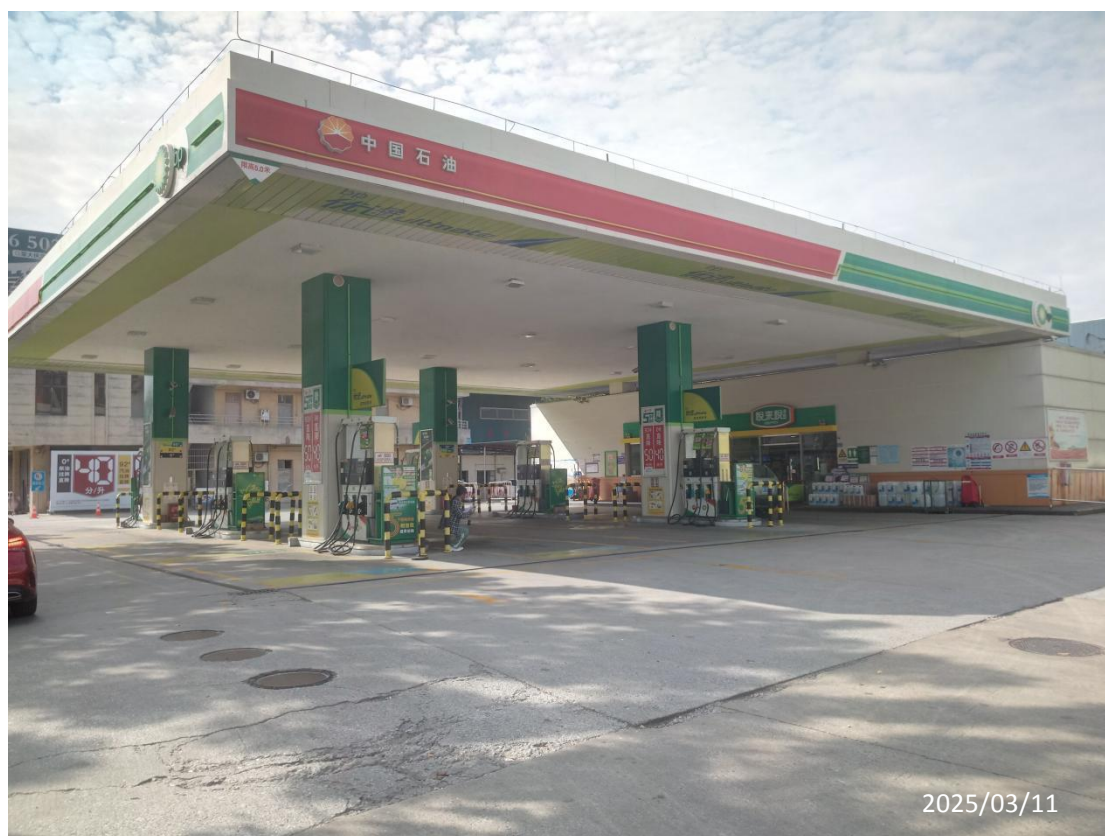
中油碧辟石油有限公司东莞江南加油站现场照片
