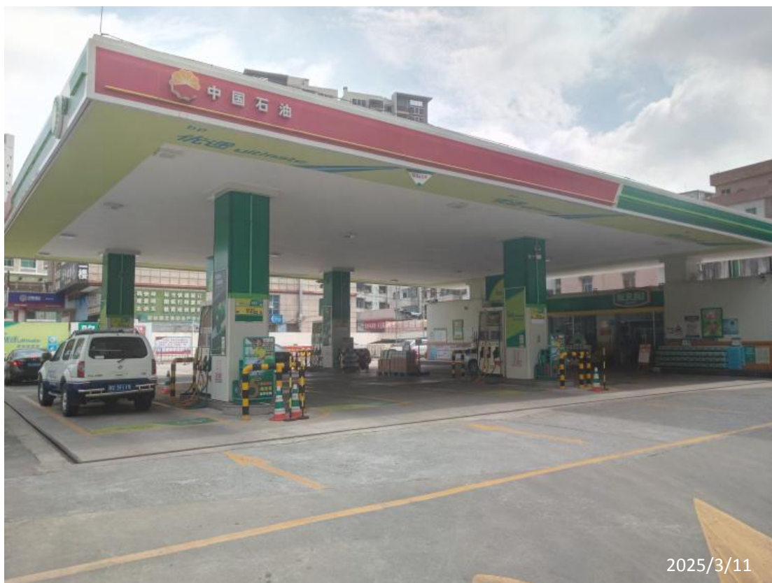
中油碧辟石油有限公司东莞南城区加油站现场照片
