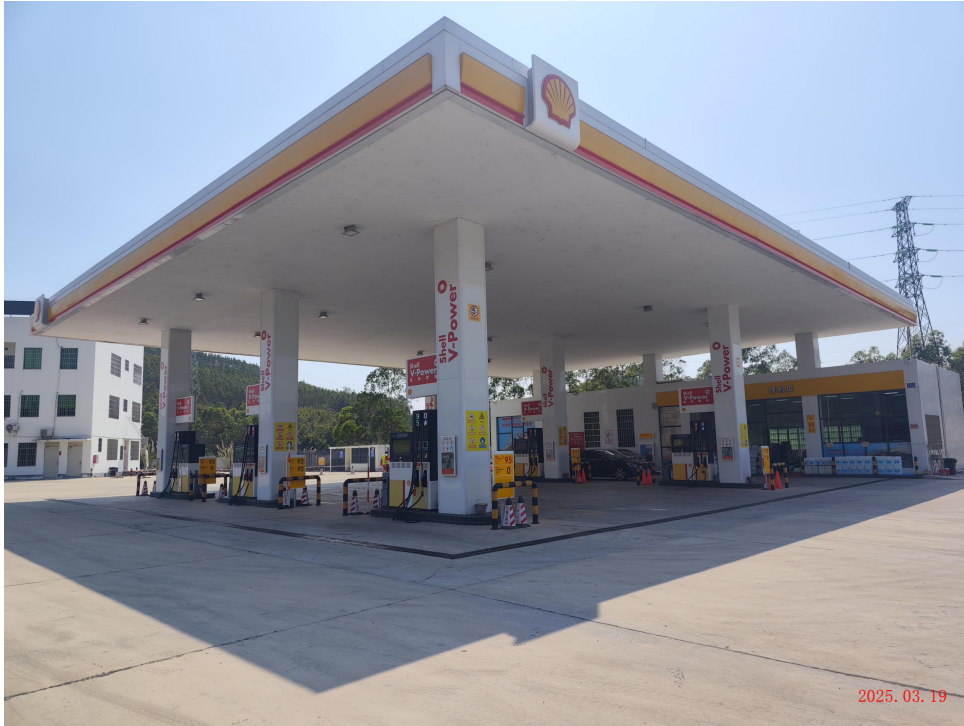
鹤山市粤西石化加油站有限公司现场勘察影像：
