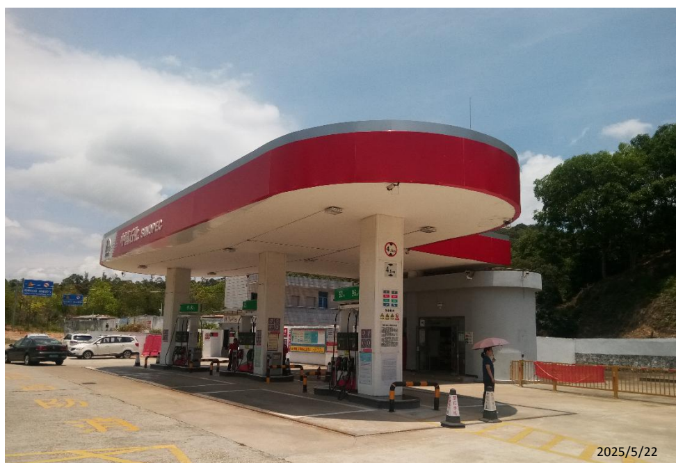
深圳市南澳经济发展有限公司龙南加油站现场勘察影像：
