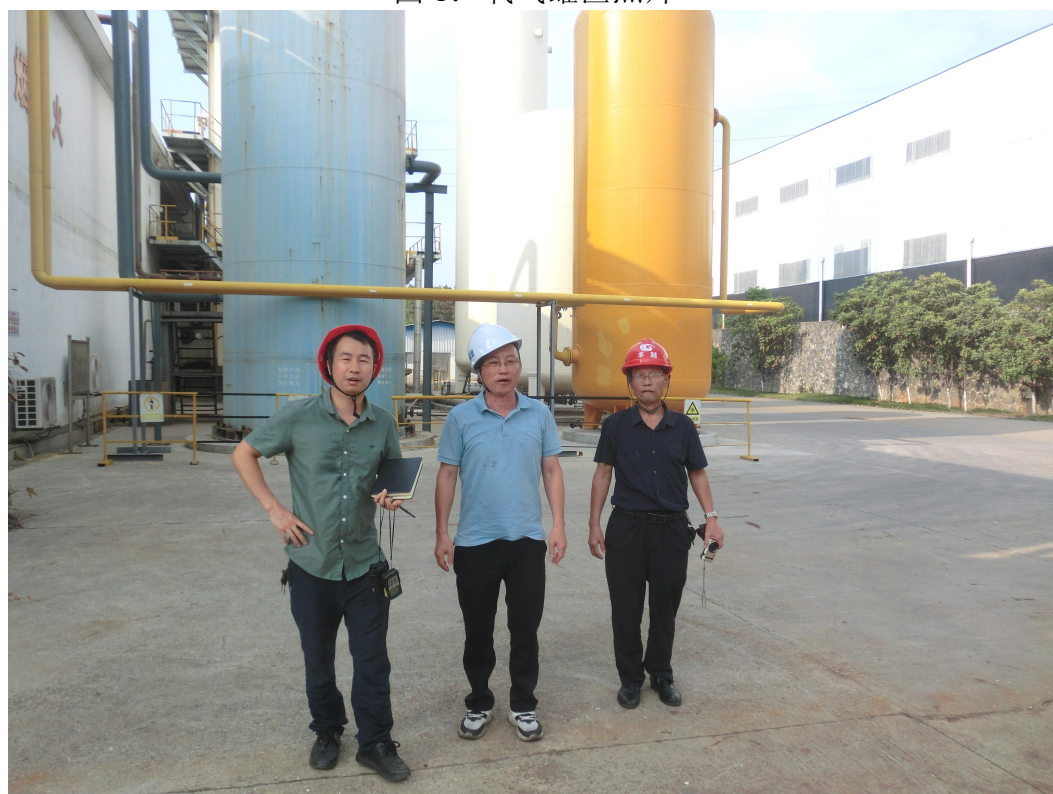
图 2：评价人员现场勘察图片
