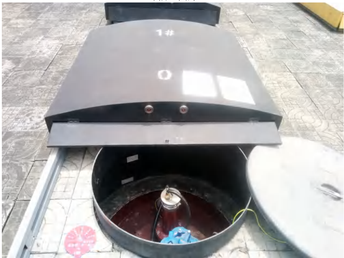
油罐人孔操作井图片
