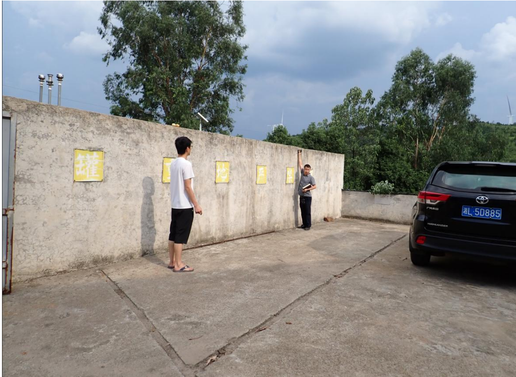
永兴县油麻供销合作社加油站现场勘察影像：（现场勘察时间：2025年9月5日）
