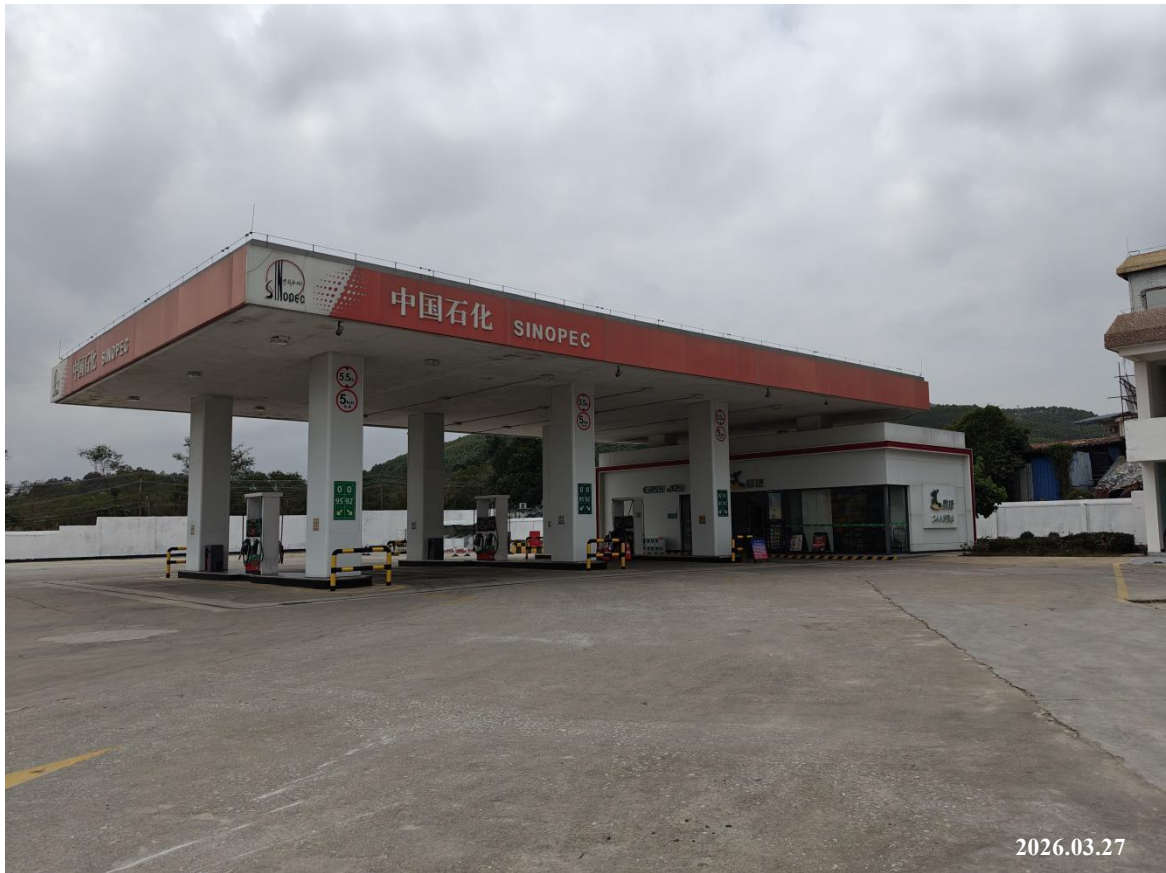
中国石化销售股份有限公司广东惠州惠东建福加油站现场照片
