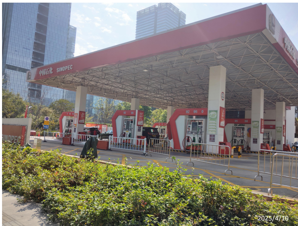
中国石化销售股份有限公司广东深圳科技园南加油站现场勘察影像：
