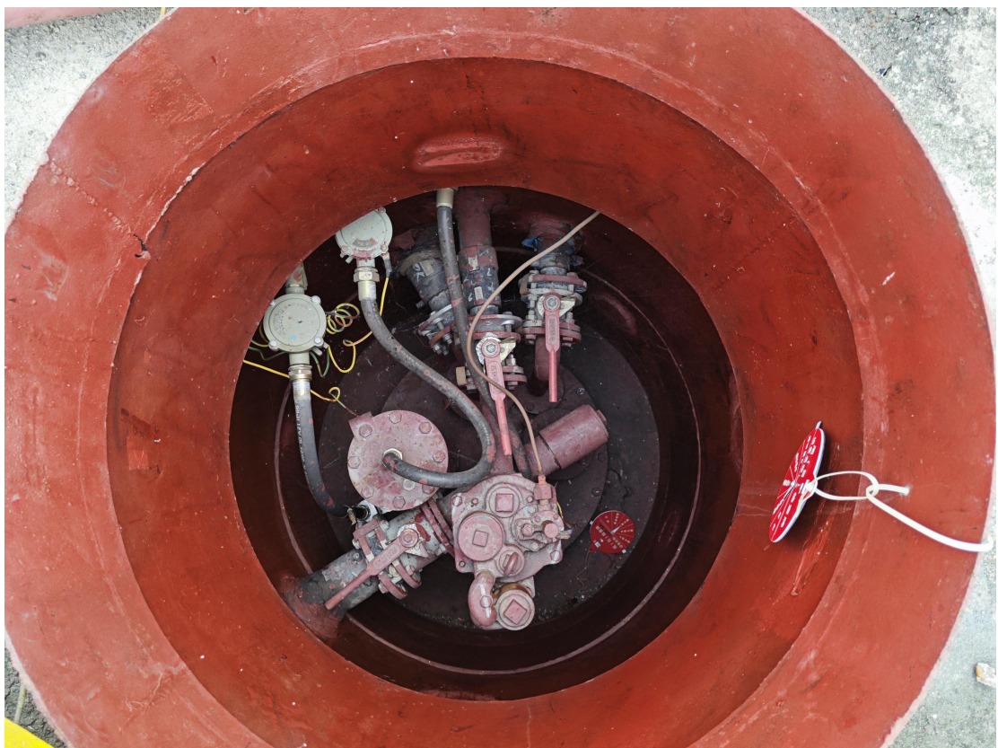
油罐人孔操作井照片
