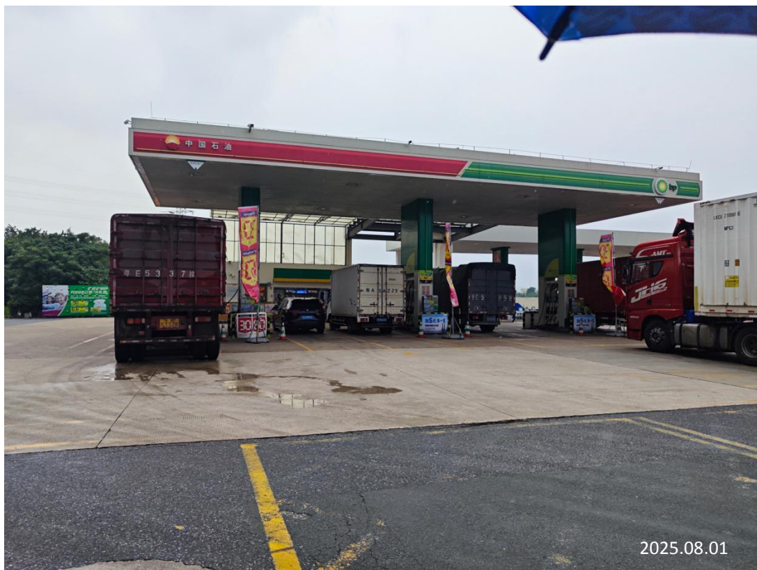
中油碧辟石油有限公司广州西二环高速公路服务区西区加油站现场勘察影像：
