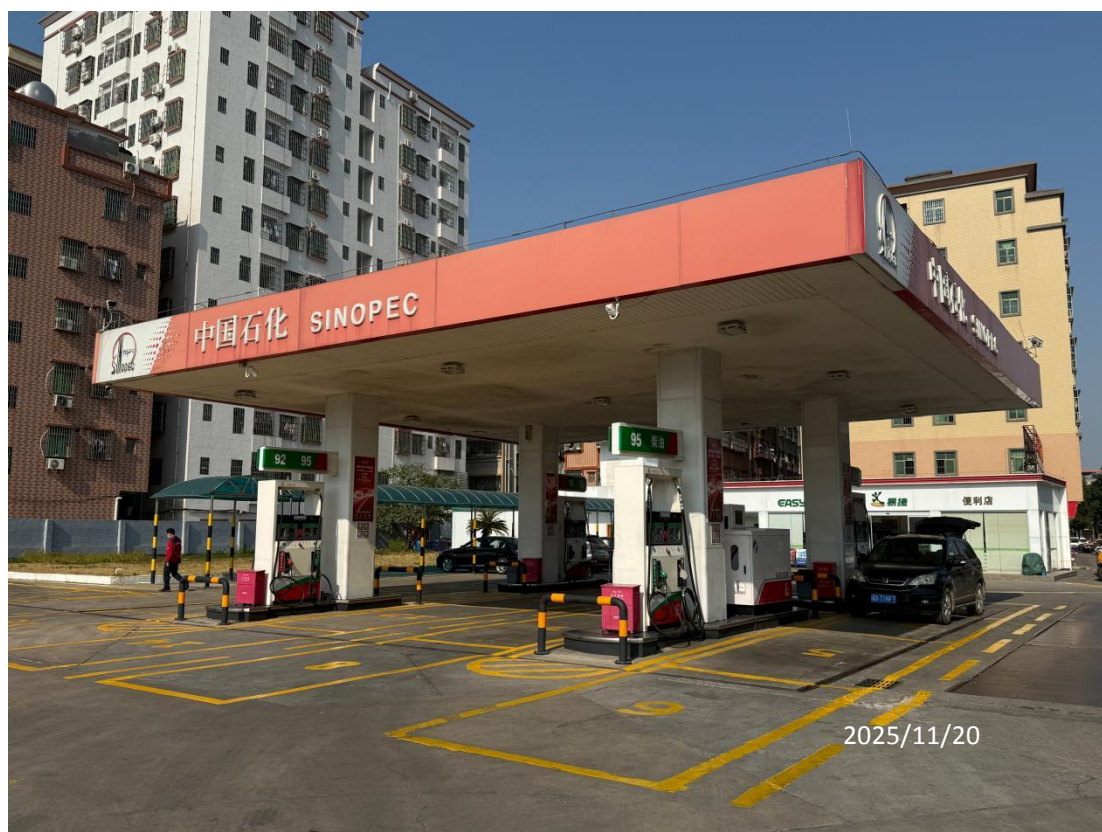
中国石化销售股份有限公司广东东莞桥头桥龙加油站现场照片
