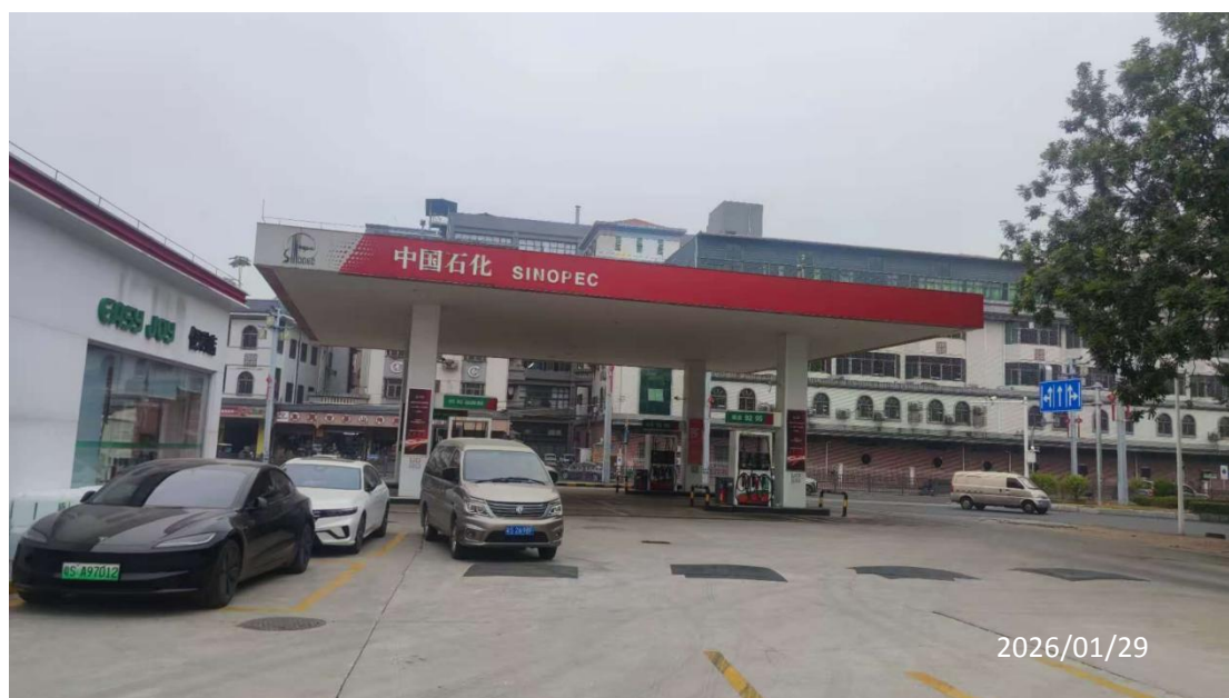
中国石化销售股份有限公司广东东莞茶山南华加油站现场照片
