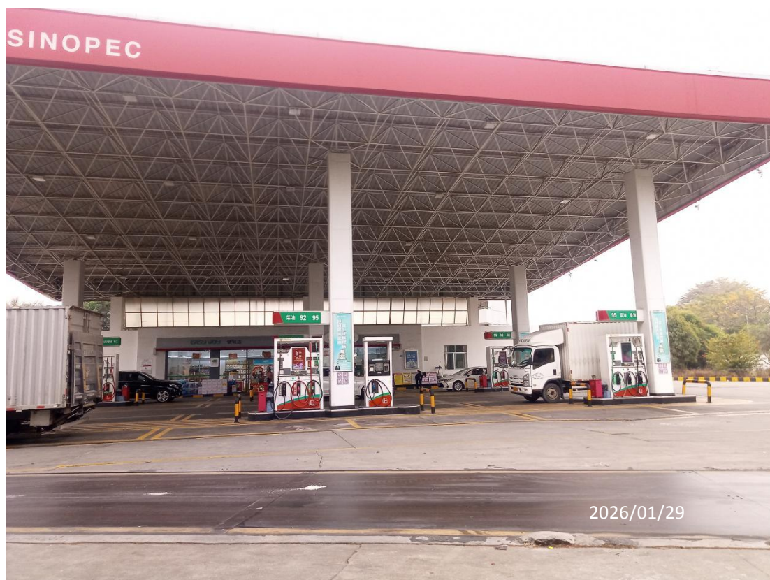
中国石化销售股份有限公司广东东莞寮步浮竹山加油站现场照片
