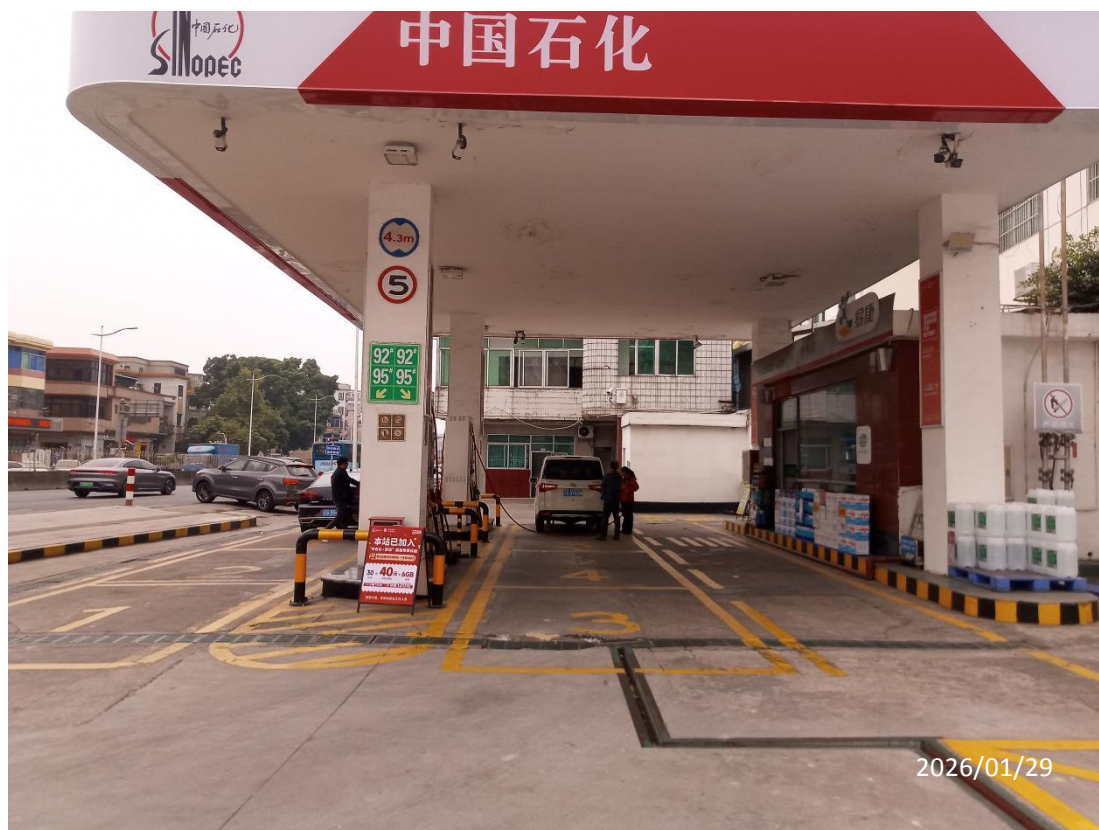
中国石化销售股份有限公司广东东莞寮步寮城加油站现场照片
