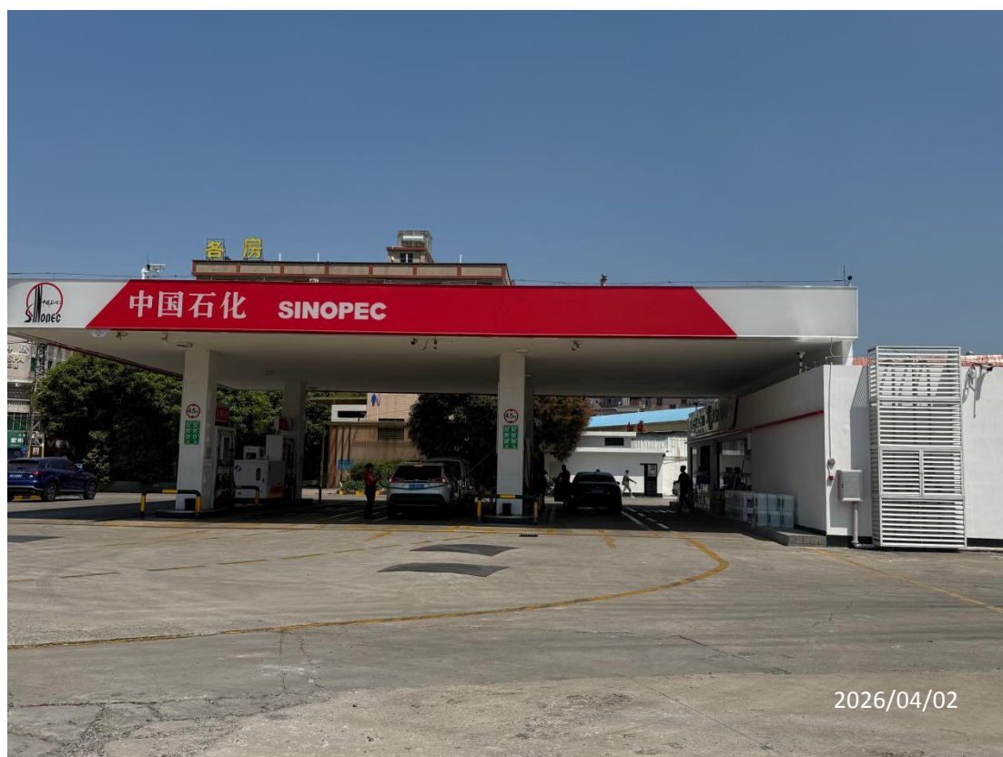
中国石化销售股份有限公司广东东莞东坑骥德加油站现场照片
